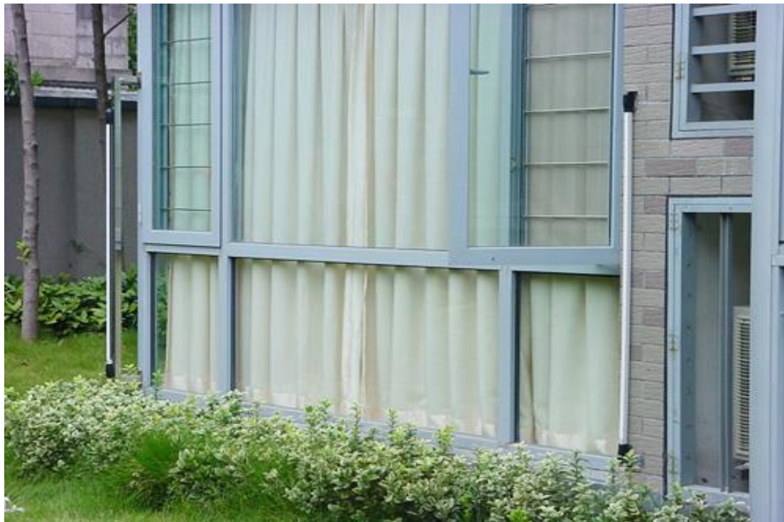
Рисунок 1.2 - Вариант установки извещателя для охраны оконного проема
